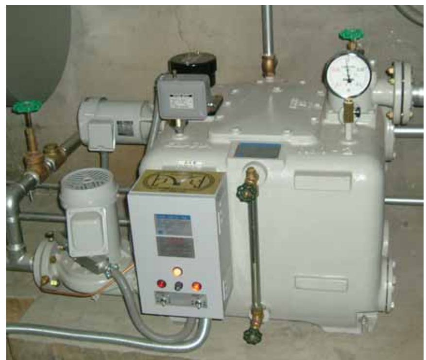
真空暖房ポンプ 荏原 2AC1K5型
